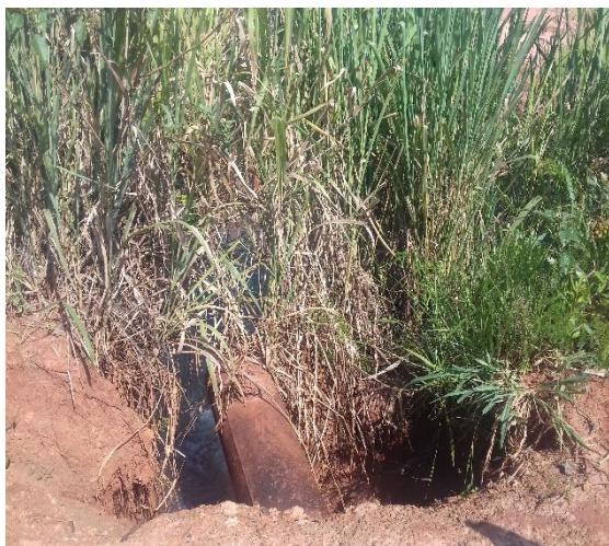
Lançante 8 - km 4,06 – baixada / tubo existente
