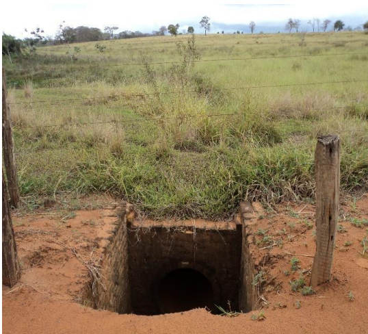
Lançante 8 - km 3,66 – baixada /tubulação
