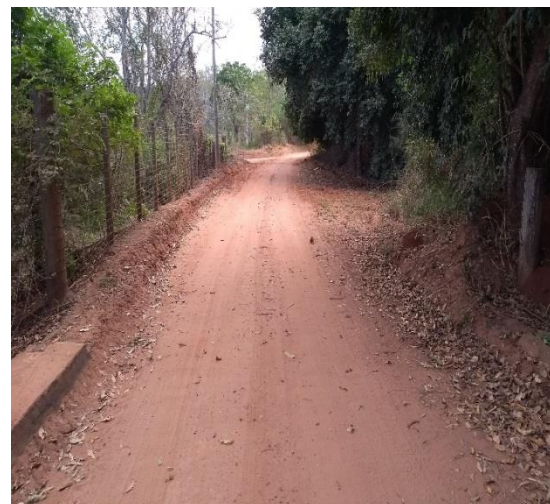
Lançante 4 - km 3,66 – baixada/ré (ponte concreto)
