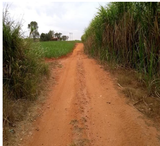
Lançante 2 - km 2,78 – Meio de Lançante Ré
