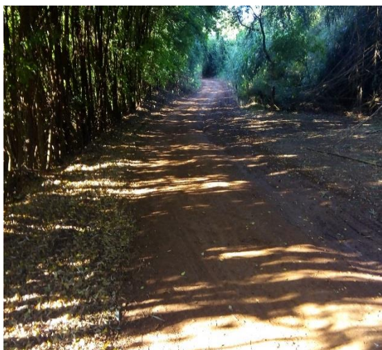
Lançante 1 - km 0,00 – baixada (ponte)
